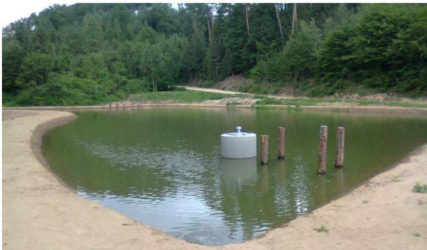
Zugschwert-Teich knapp vor Fertigstellung, im Vordergrund der Mönch
