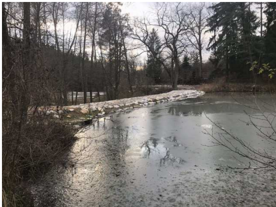
Neue Überlaufmulde und Überfahrt
